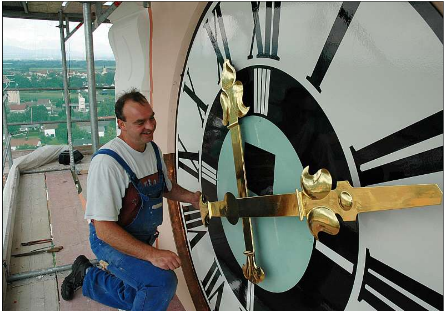
Ein Arbeitsplatz in luftiger Höhe: Feinwerkmechaniker Michael Ermer hat gestern die Zeiger auf die Zifferblätter des Turms der Basilika in Altenmarkt montiert. Die Zeit wird erst eingestellt, wenn das Baugerüst abgebaut ist. – Foto: Heyd
